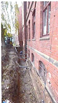
Die R. Schmidt Bauunternehmung GmbH führte die Sanierungsarbeiten aus. Im November begann die Firma mit den Abbrucharbeiten des Betonsockels vor der Außenwand, vor den Kellerfenstern und den alten Kellerlichtschächten. Nachdem der Boden vor der Kellerwand ausgehoben, abgefahren und entsorgt war, mussten die Wandoberflächen gereinigt, abgerieben, geglättet und grundiert werden. Danach wurden Dämmplatten montiert und die Kellerlichtschächte neu aufgemauert.
